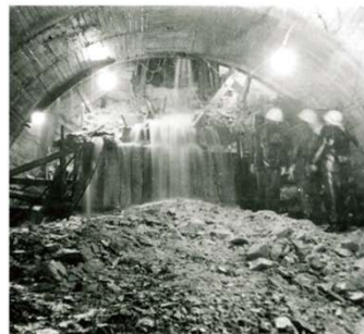
4℃の冷水が最大で毎秒660ℓも噴出した破碎帯(提供:関西電力)
